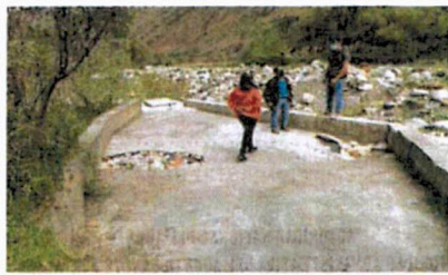
LAS ESTRUCTURAS DE CAPTACION ESTAN EN INMINENTE PELIGRO PROTEGIDAS CON ROCAS Y MUROS DE CONCRETO
