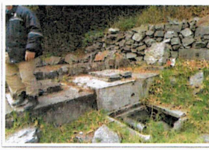
ESTRUCTURA DE CAPTACION PARA EL DISTRITO DE CHURIN CENTRO TURISTICO EN PRECARIA CONDICIONES
